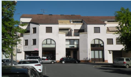
Siège administratif (Niveau 1) GOA (Rez-de-chaussée) 35, Cours Alsace Lorraine 47190 AIGUILLON
