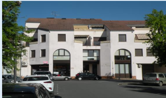
Siège administratif (Niveau 1) GOA (Rez-de-chaussée) 35, Cours Alsace Lorraine 47190 AIGUILLON
