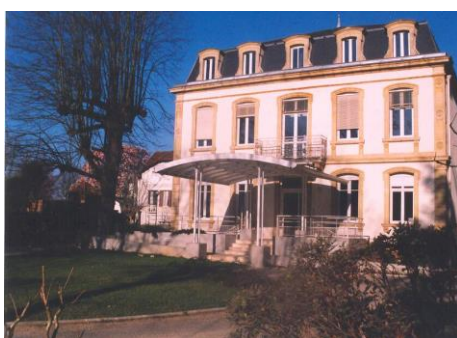
Site de Villeneuve-sur-Lot
